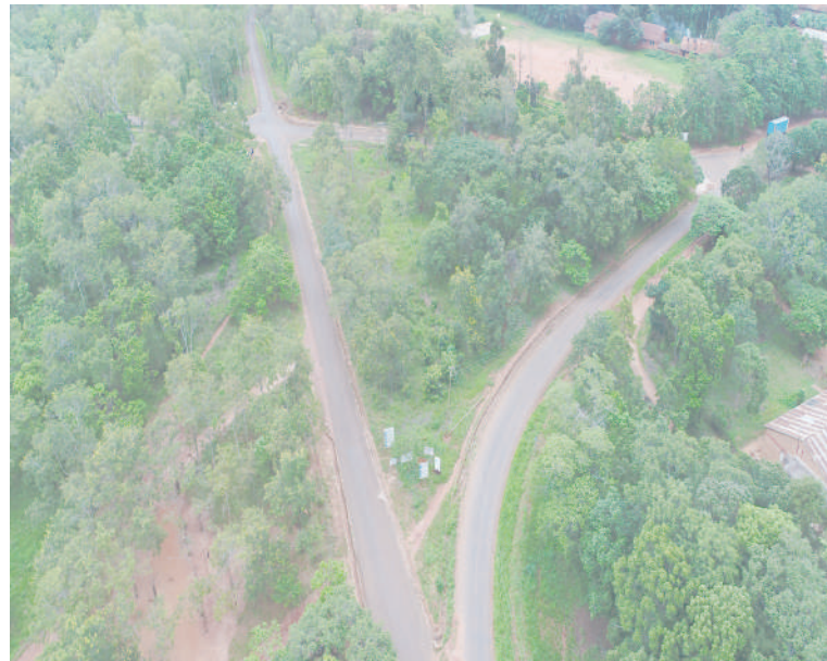
Mwonekano wa Barabara ya Peramiho-Morogoro-Nakahuga yenye urefu wa Km 7.34 iliyojengwa na TARURA katika Halmashauri ya Wilaya ya Songea mkoani Ruvuma.
