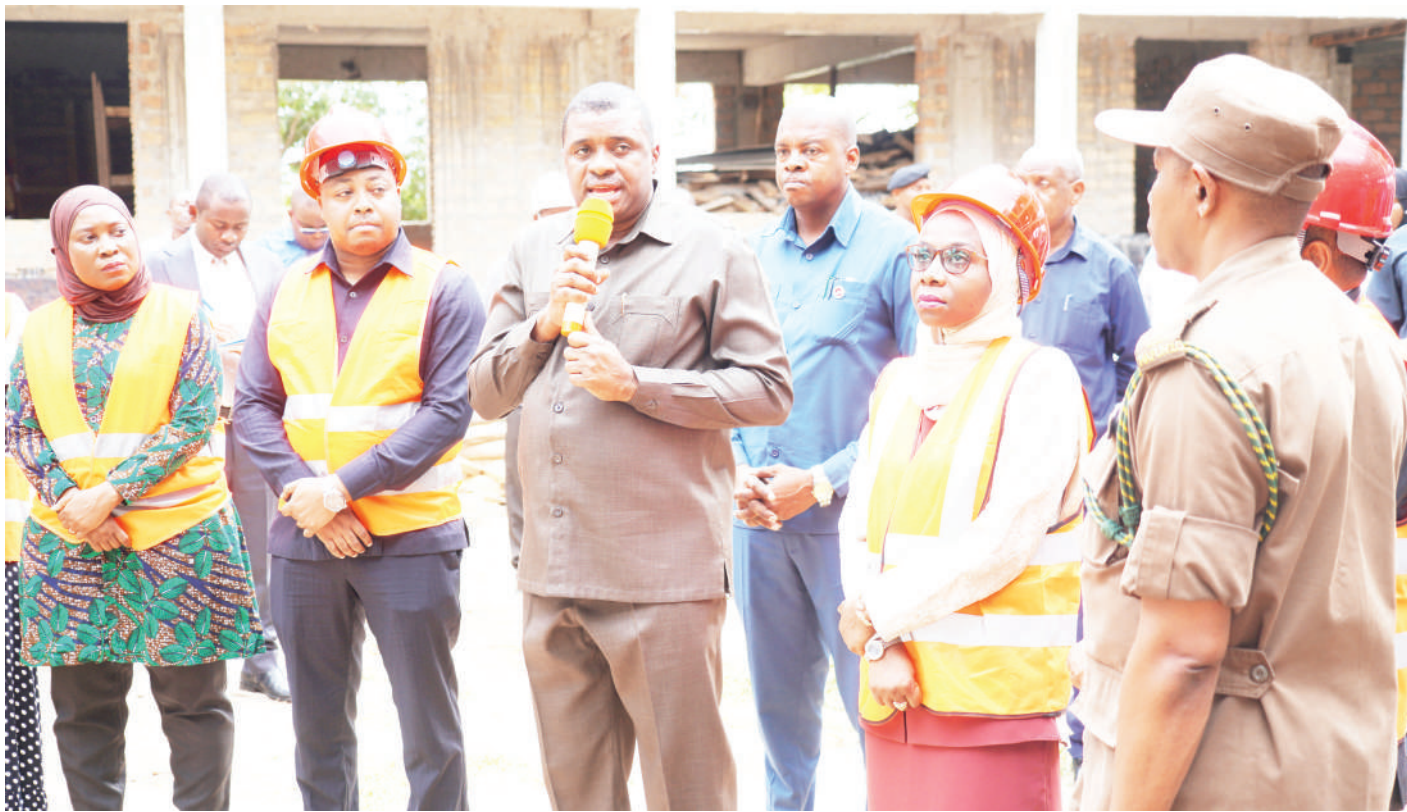
Makamu wa Pili wa Rais wa Zanzibar, Hemed Suleiman Abdulla, akizungumza alipofanya ziara ya kukagua ujenzi wa Shule ya Munduli, Wilaya ya Magharibi "A" jana, inayojengwa kwa fedha za mkopo wa ahueni ya Uviko-19. PICHA: MPIGAPICHA WETU
