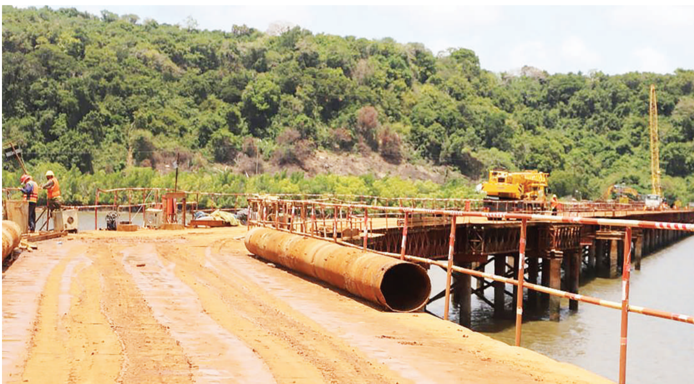
Daraja la mto Pangani lenye urefu wa mita 525 na barabara unganishi (Km 14.3), mkoani Tanga zikiendelea kujengwa. Daraja hili linajengwa na mkandarasi Shandong Luqiao Group. PICHA: WIZARA YA UJENZI
