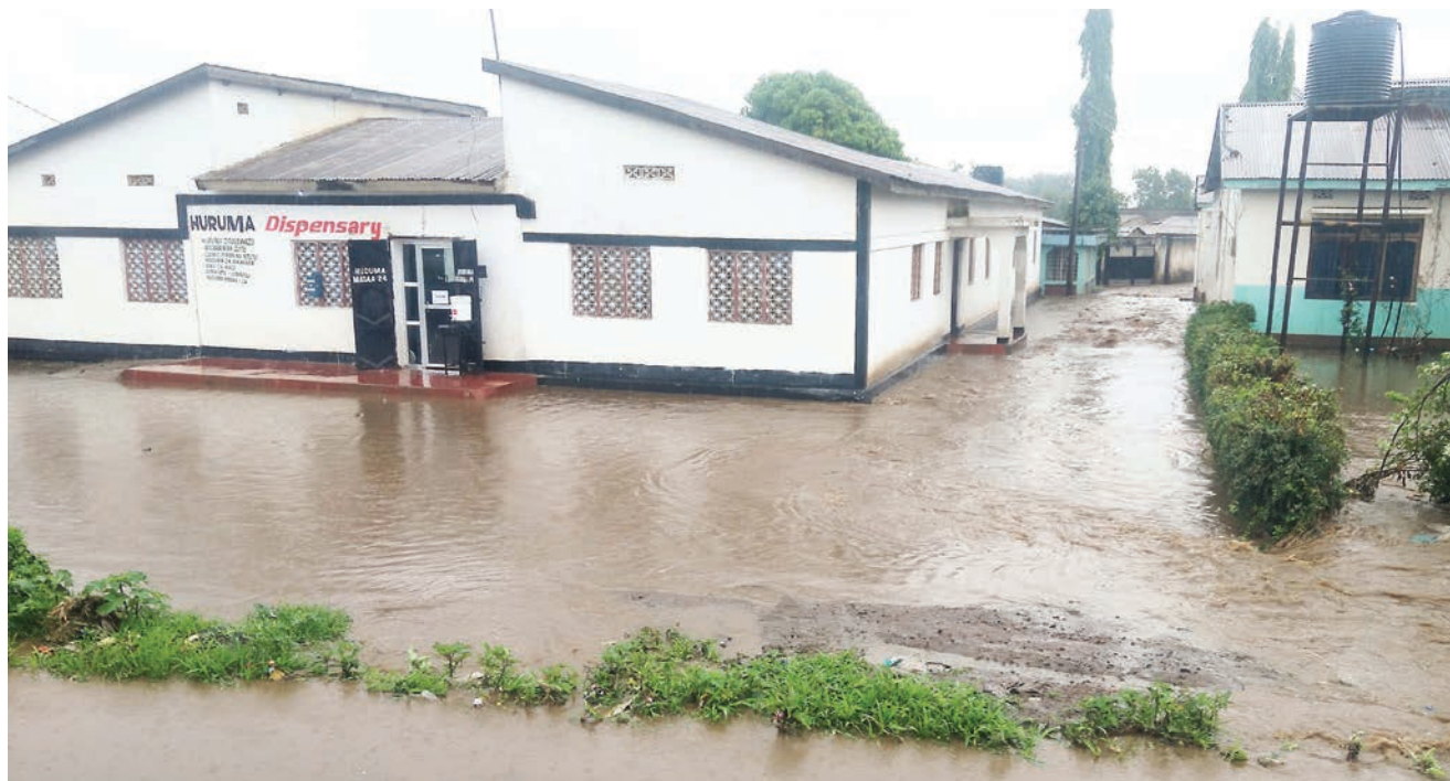
Mafuliro yakiwa yamevamia makazi ya watu katika Mamlaka ya Mji Mdogo wa Mbalizi mkoani Mbeya baada ya mifereji ya barabara kuu ya Tanzania na Zambia (TANZAM) kushindwa kuhimili maji ya mvua mwishoni mwa wiki. PICHA: NEBART MSOKWA
