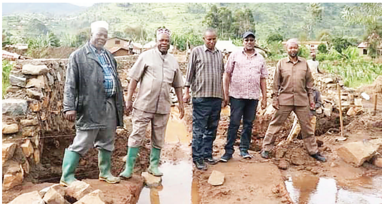
Mkuu wa Wilaya ya Lushoto mkoani Tanga, Kalist Lazaro (Wapili kulia) akiwa na viongozi wenzake katika ziara ya kutembelea kata za Dule na Mwangoi kukagua ujenzi wa daraja lililopo eneo la Mlesa pamoja na barabara ya Majulai-Mlesa. Picha: STEVEN WILLIAM
