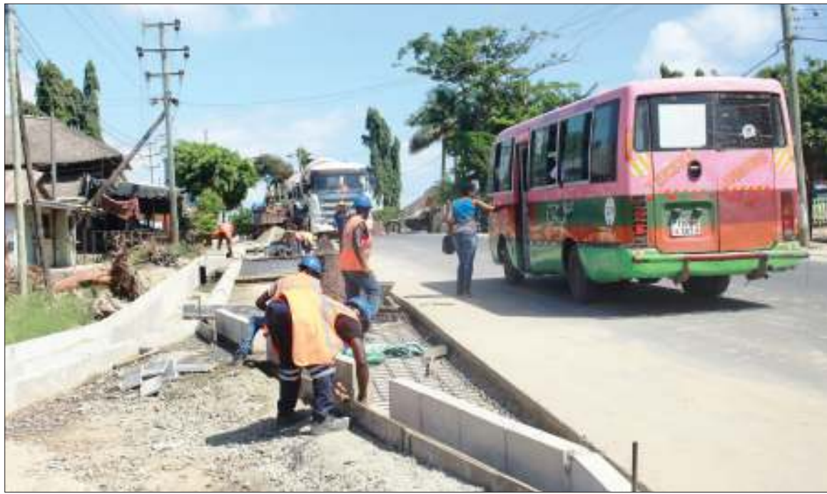
Wafanyakazi wa kampuni ya ujenzi ya CCECC, wakiendelea na ujenzi wa vituo vya mabasi katika Barabara ya Mlandizi inayoanzia Sinza Kijiweni hadi Tandale kwa Mtogole, jijini Dar es Salaam jana. Picha: HALI-MAMA KAMBI
