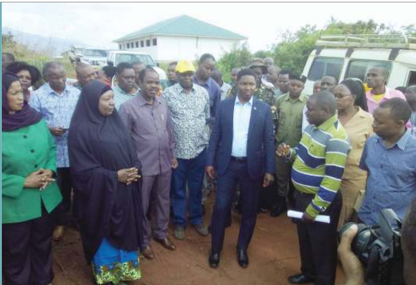
Waziri wa Tamisemi, Selemani Jafo (katikati), akipewa maelezo ya ujenzi wa hospitali mpya ya Wilaya ya Muheza jana na Kaimu Mhandisi wa Wilaya hiyo, Ramadhani Mtinge (kulia). Wengine ni Mkuu wa Mkoa wa Tanga, Martini Shigela na Mkuu wa Wilaya ya Muheza, Mwanasha Tumbo. PICHA: STEVEN WILLIAM
