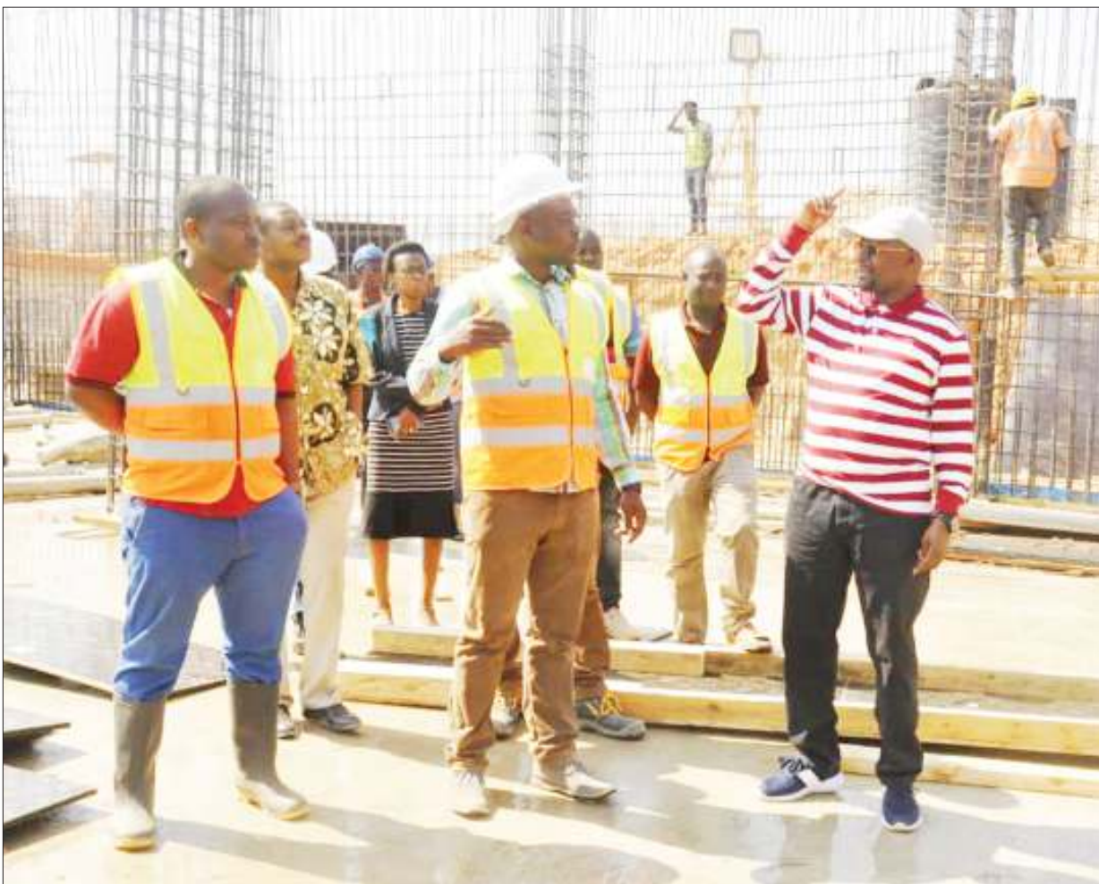
Naibu Katibu Mkuu wa Wizara ya Mambo ya Ndani, Ramadhani Kailima (kulia), akisisitiza jambo wakati alipokagua ujenzi wa jengo la Idara ya Uhamiaji Makao Makuu mjini Dodoma juzi. PICHA: WMNN
