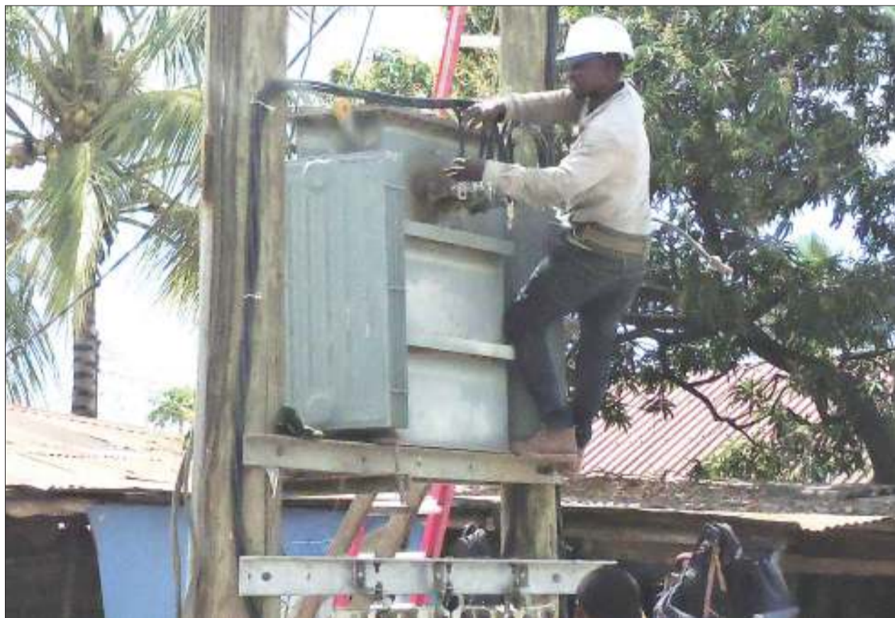
Mafundi wa Shirika la Ugavi Umeme Tanzania (Tanesco), wakiten-geneza transfoma iliyopata hitilafu katika eneo la Tandale kwa Mtogole, Manispaa ya Kinondoni, jijini Dar es Salaam jana. PICHA: GETRUDE MPEZYA
