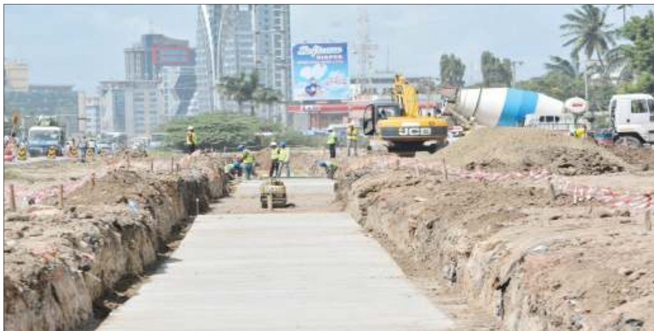
Wafanyakazi wa kampuni ya ujenzi ya Mac, wakifunika bomba la maji kwa zege kabla ya kuanza upanuzi wa barabara ya Mwenge-Morocco katika eneo la Mwenge, jijini Dar es Salaam jana. PICHA: MIRAJI MSALA
