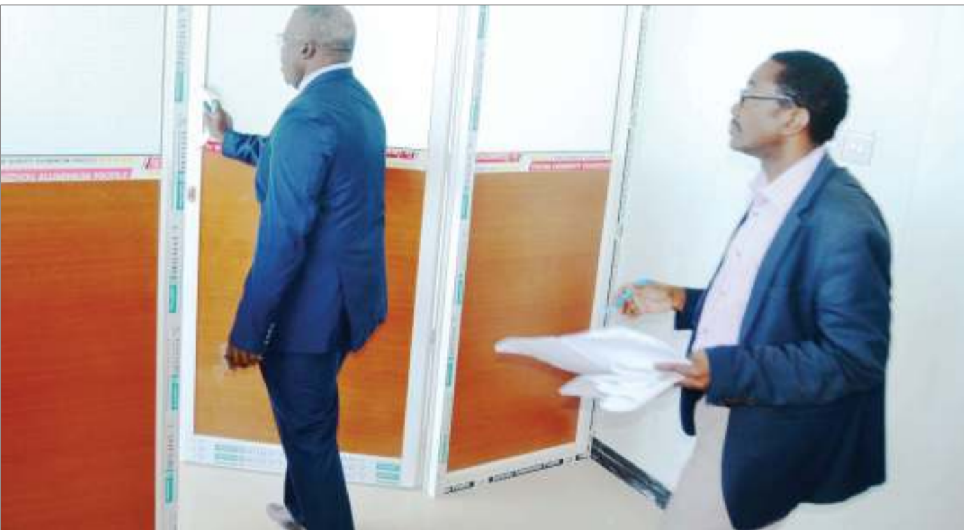
Katibu Mkuu wa Wizara ya Ujenzi, Uchukuzi na Mawasiliano (Sekta ya Ujenzi), Elius Mwakalinga (kushoto), akikagua moja ya miradi inayojengwa na Wakala wa Majengo nchini (TBA), kwa kushirikiana na vikosi vya ujenzi na Wakala wa Ufundi na Umeme (TEMESA), mjini Dodoma jana. PICHA: WUUM
