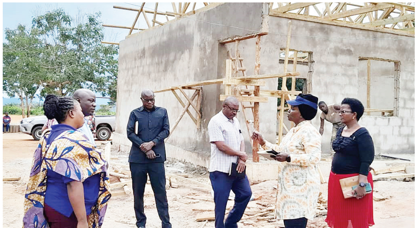
Mkurugenzi Msaidizi Elimu wa Msingi wa TAMISEMI, Suzani Nusu (wa pili kulia), akikagua ujenzi wa mabweni na madarasa katika Shule ya Sekondari ya Muheza juzi kwenye Kijiji cha Mwembeni, Kata ya Magoroto. Miradi hiyo inajengwa kwa fedha za Boast. PICHA:STEVEN WILLIAM
