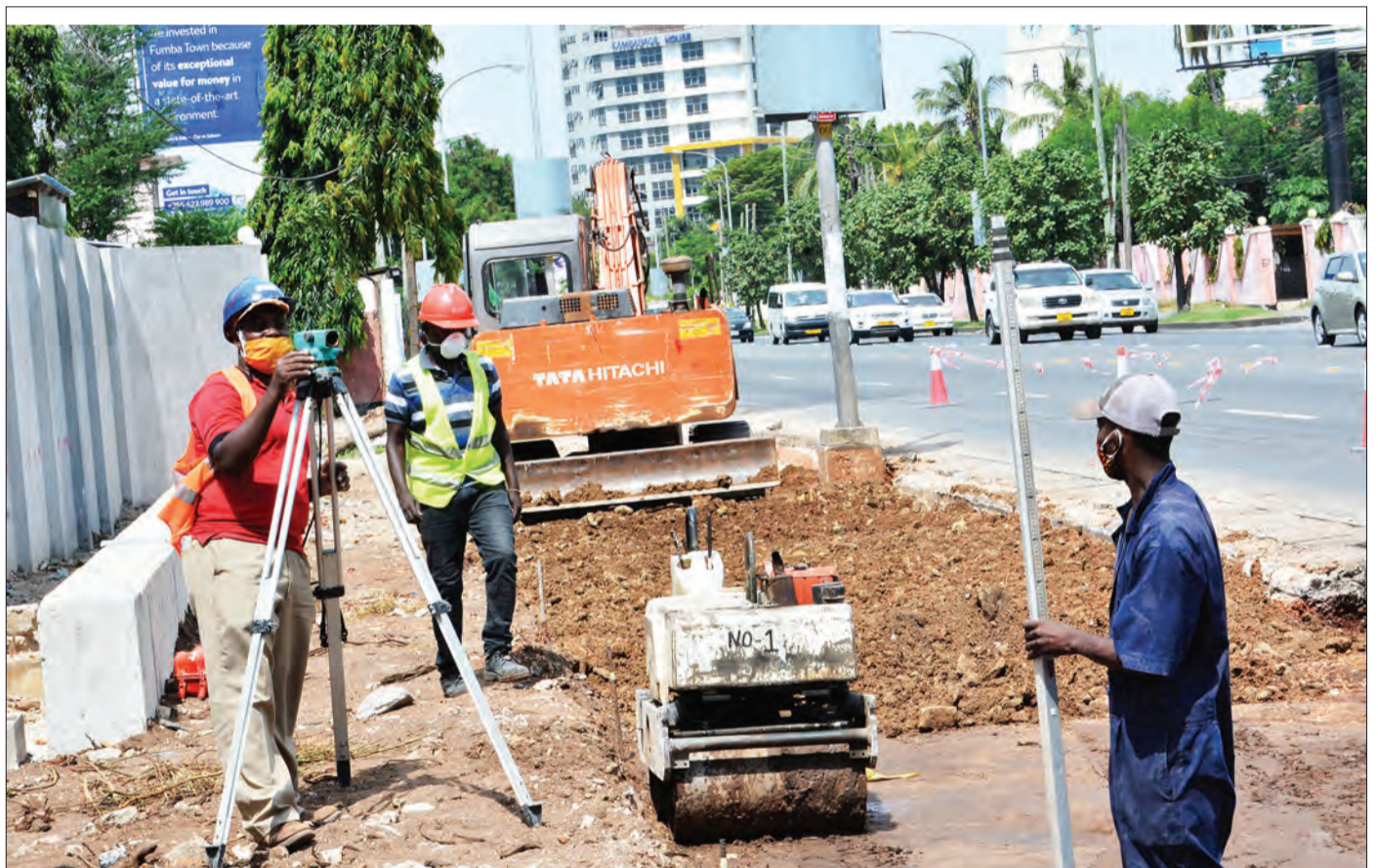
Mafundi wa kampuni ya ujenzi ya Estim, wakiendelea na kazi ya ujenzi wa kituo cha daladala cha Palm Beach katika Barabara ya Ali Hassan Mwinyi, eneo la Upanga, jijini Dar es Salaam jana. PICHA: MIRAJI MSALA.
