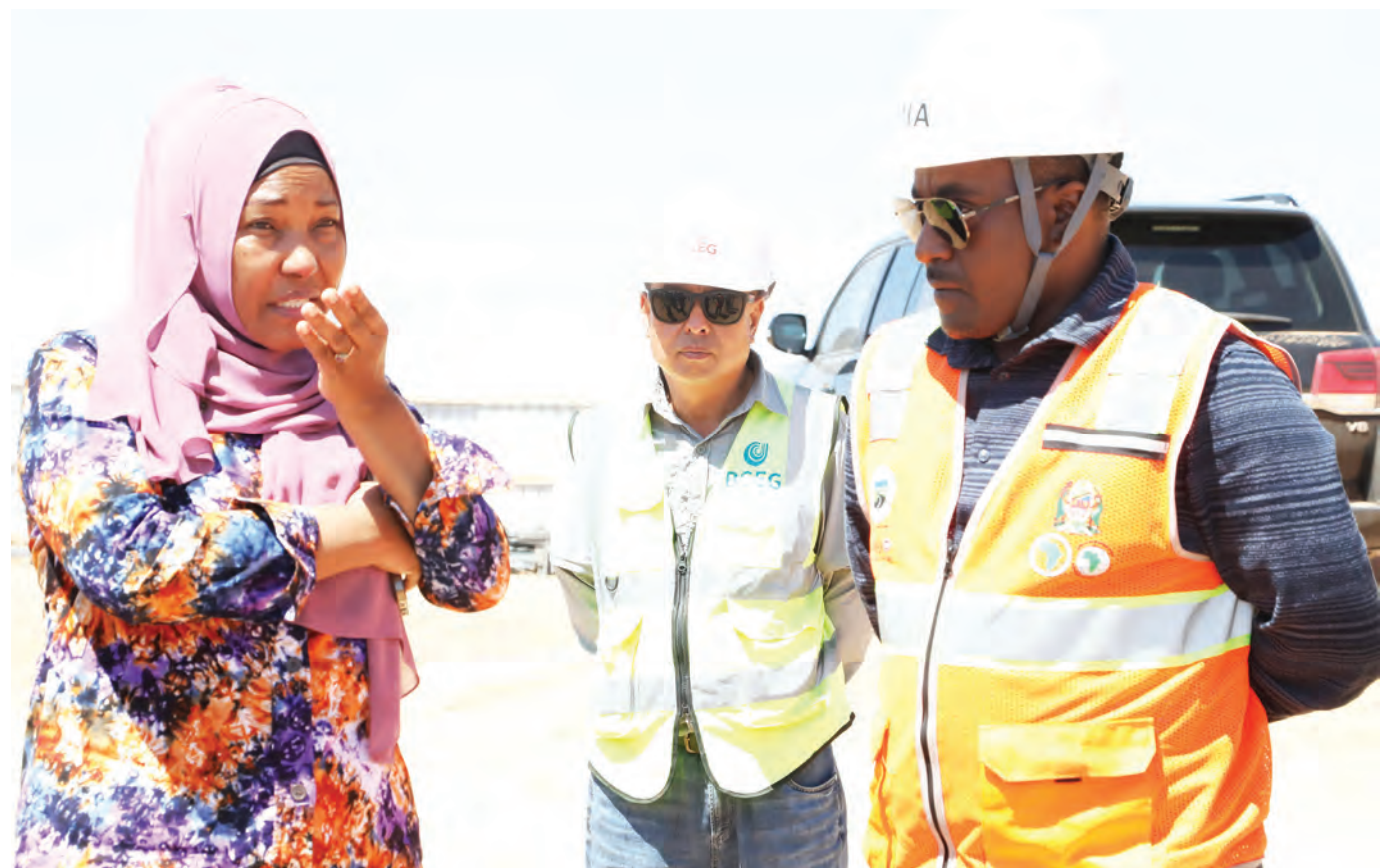
Katibu Mkuu Wizara ya Ujenzi na Uchukuzi, (Sekta ya Ujenzi), Balozi Aisha Amour, akitoa maelekezo kwa Mshauri mwelekezi wa Mradi wa Ujenzi wa Kiwanja cha Ndege cha Kimataifa cha Msalato, Mhandisi Shegan Berharie, alipokuwa akikagua maendeleo ya mradi huo jana, mkoani Dodoma. PICHA: WJU
