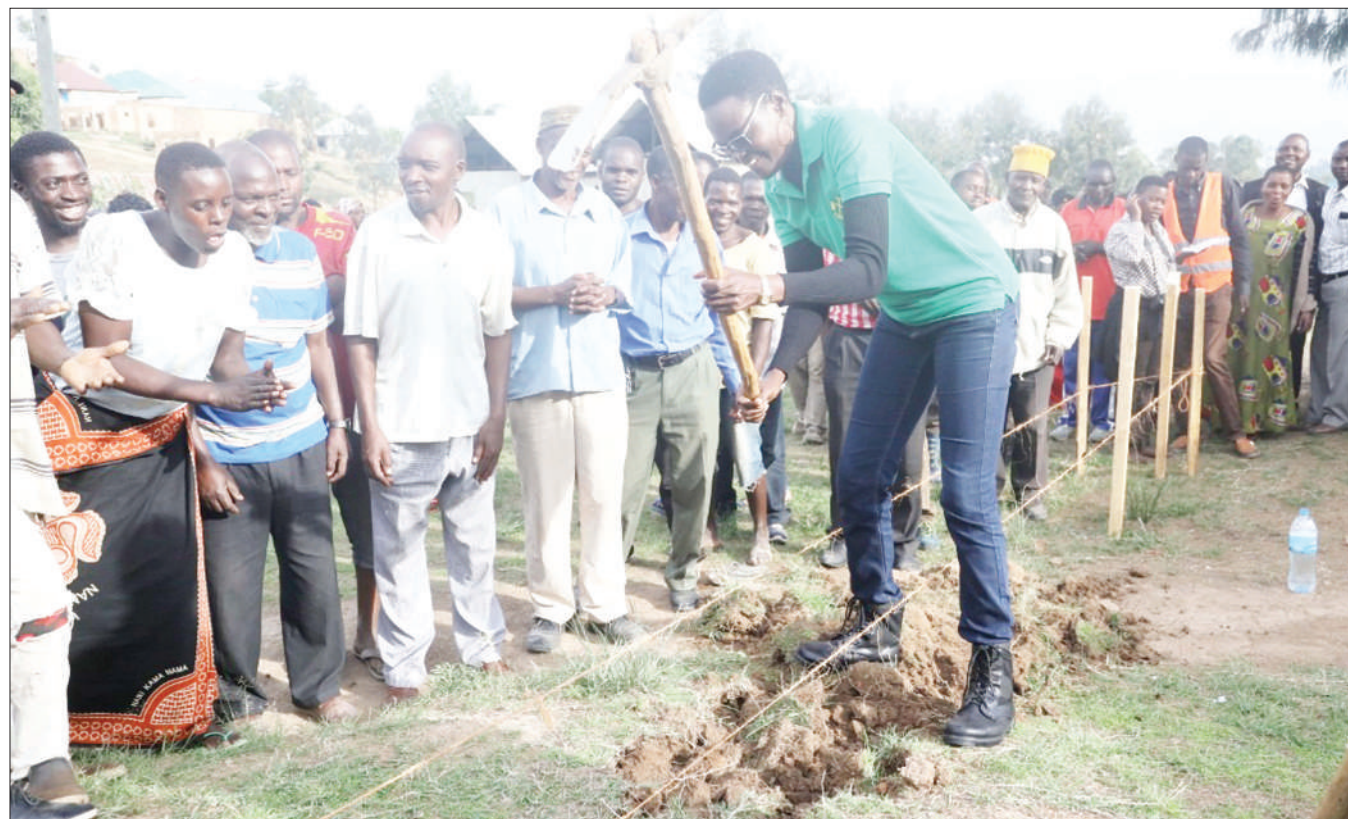
Mbunge wa Mbeya Mjini, Dk. Tulia Ackson ambaye ni Naibu Spika wa Bunge, akishiriki kuchimba msingi wa ujenzi wa vyumba sita vya madarasa katika Shule ya Sekondari Iganzo iliyoko Halmashauri ya Jiji la Mbeya, pia aliahidi kuchangia mifuko 200 ya saruji, ujenzi wa vyumba hivyo unataraji kukamilika Januari 11 mwaka 2021, ili vitumike kwa wanafunzi 435 wa kidato cha kwanza. PICHA: GRACE MWAKALINGA
