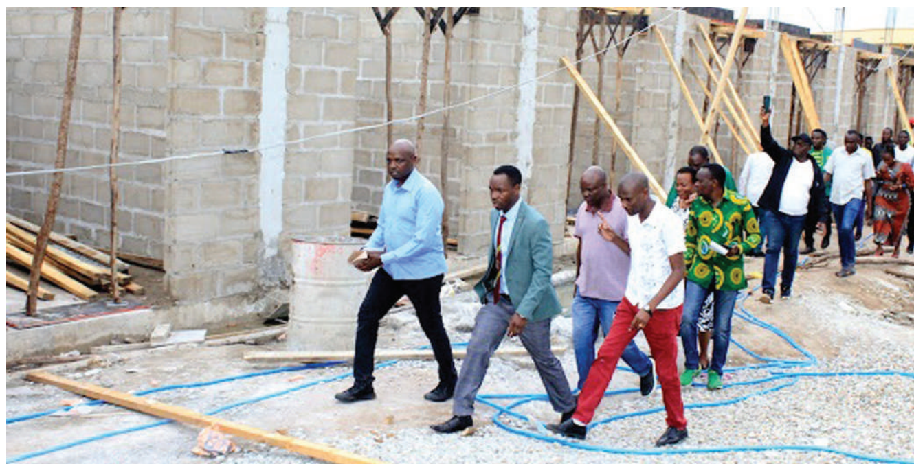
Mbunge wa Jimbo la Shinyanga Mjini, Patrobas Katambi ambaye ni Naibu Waziri Ofisi ya Waziri Mkuu anayeshughulikia Kazi, Vijana, Ajira na Wenye ulemavu (katikati), akikagua ujenzi wa soko kuu la Manispaa ya Shinyanga unaogharimu Sh. bilioni 1.8, (kushoto) ni Mkurugenzi wa Manispaa ya Shinyanga, Jomaary Satura. PICHA: MARCO MADUHU
