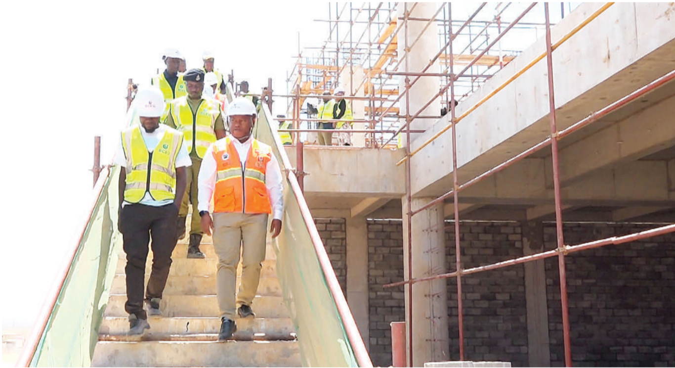
Mkuu wa Wilaya ya Dodoma, Jabir Shekimweri (kulia), akikagua maendeleo ya ujenzi wa Uwanja wa Ndege wa Kimataifa wa Msalato, juzi. PICHA: PETER MKWAVILA
