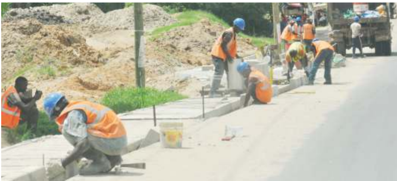
Mafundi wakiendelea na kazi ya ujenzi wa kingo za barabara iliyojengwa kwa kiwango cha lami ya Sinza - Tandale, katika eneo la White Inn, jijini Dar es Salaam jana. PICHA: JOHN BADI
