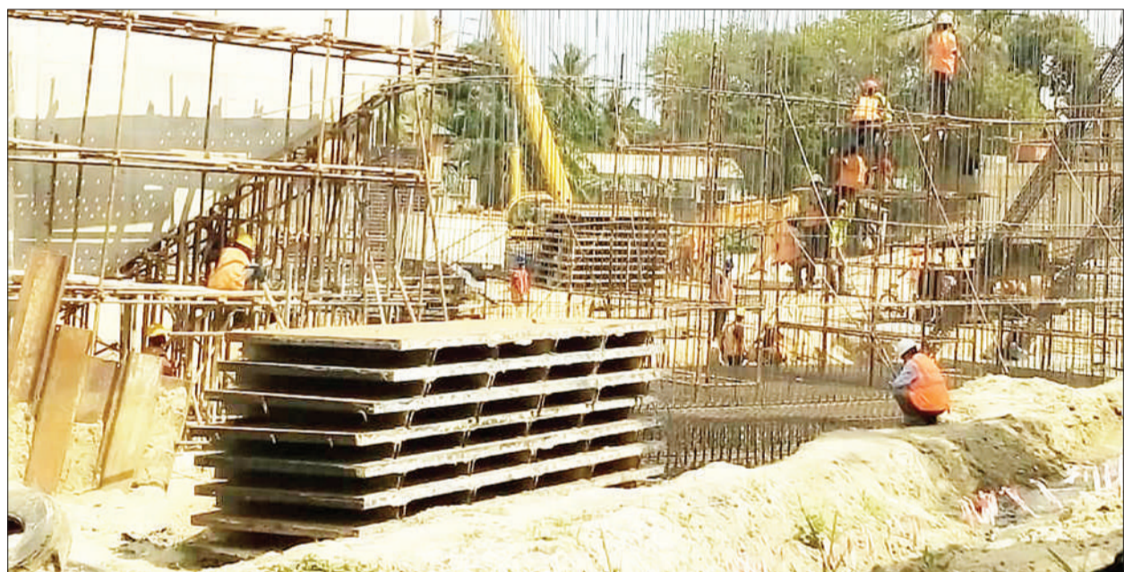
Mafundi wakiendelea na ujenzi wa miundombinu ya barabara za juu (Ubungo Interchange), katika makutano ya Barabara ya Sam Nujoma, eneo la Ubungo, jijini Dar es Salaam jana. PICHA: REBECCA MWIHOMEKE/TUDARCO
