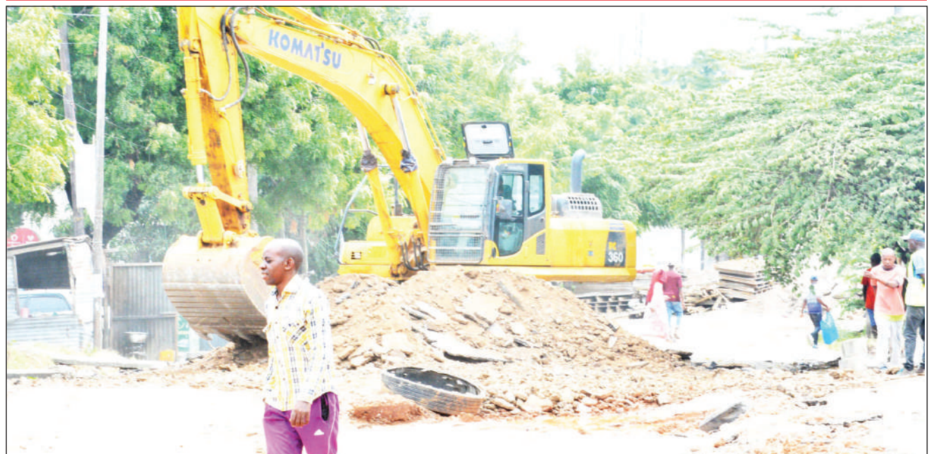
Mafundi wakiendelea na kazi ya kuondoa lami ya zamani na kuweka mpya katika eneo la Mburahati Mianzini, jijini Dar es Salaam hivi karibuni. PICHA: MIRAJI MSALA
