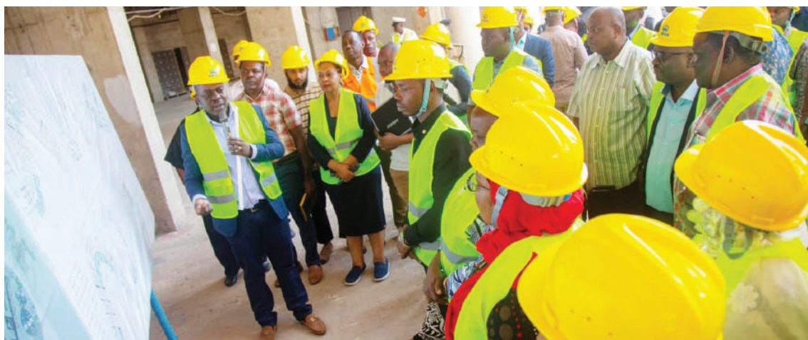
Wajumbe wa Kamati ya Kudumu ya Bunge ya Ustawi na Maendeleo ya Jamii, wakikagua maendeleo ya ujenzi wa hoteli katika mradi unaosimama na NSSF. Picha: MPIGAPICHA WETU
