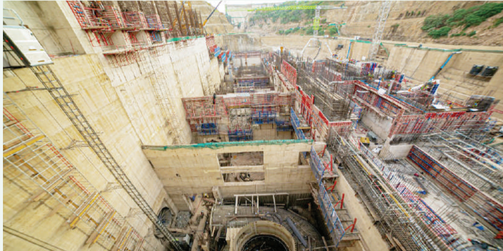
Jengo la kuendesha mitambo katika ujenzi wa mradi wa kufua umeme wa Julius Nyerere unaojengwa katika mto Rufiji, mkoani Pwani. Picha: Valentine Oforo
