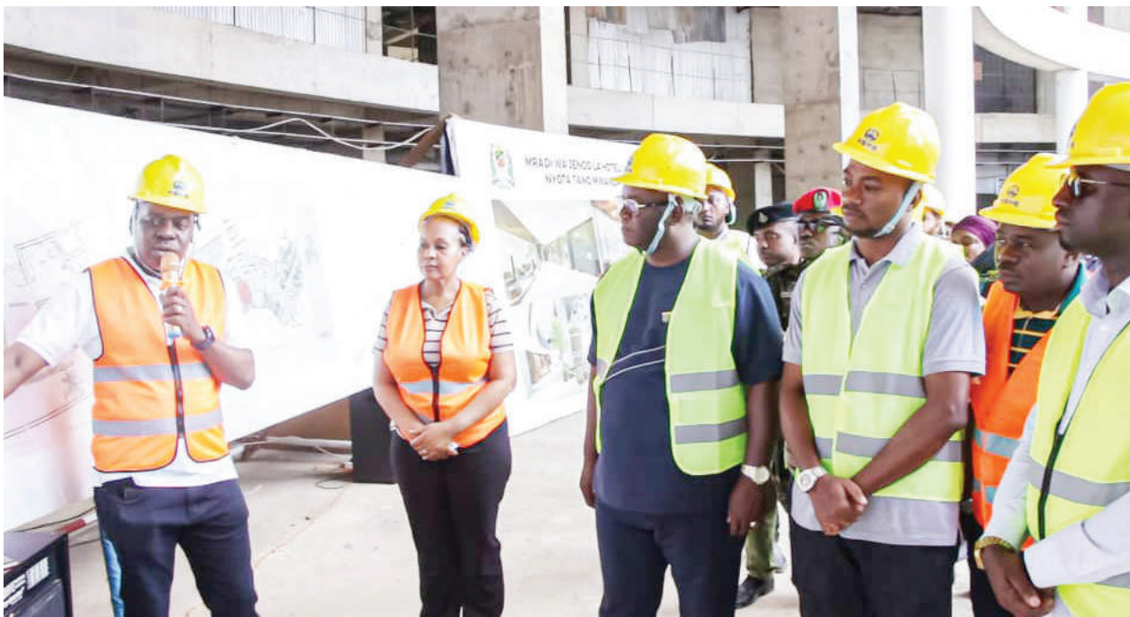
Mkuu wa Mkoa wa Mwanza, Said Mtanda (wa tatu kulia), akipata maelezo ya mradi wa hoteli ya nyota tano kutoka kwa Mhandisi Helmes Pantaleo ambaye ni Meneja Miradi wa NSSF. PICHA: MPIGAPICHA WETU
