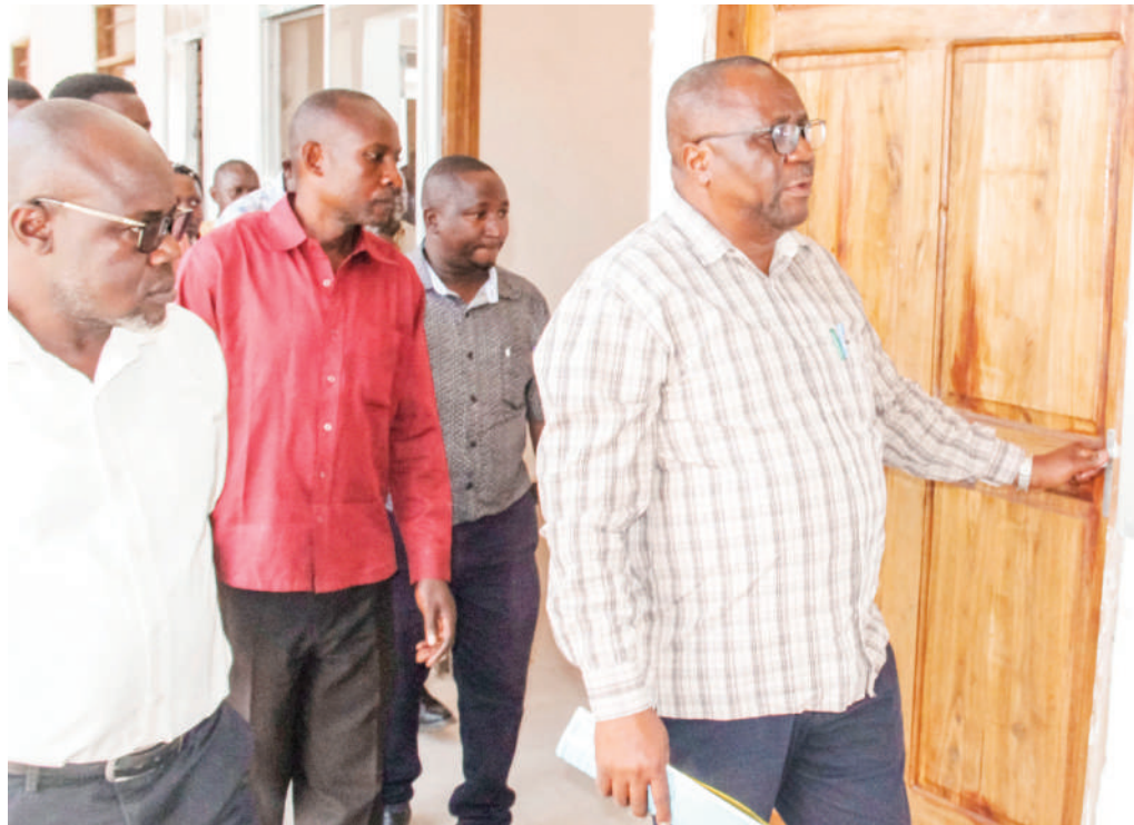
Mkuu wa Mkoa wa Shinyanga, Anamringi Macha, akikagua ujenzi wa upanuzi wa Kituo cha Afya Salawe wilayani Shinyanga juzi, alikuta milango ikiwa imetengenezwa chini ya kiwango na kuagiza ifanyiwe marekebisho ya haraka, ujenzi huo hadi sasa umeshatimia Sh.bilioni 1.2. PICHA: MARCO MADUHU
