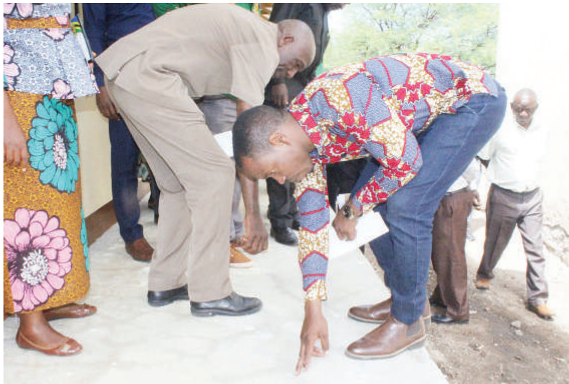
Mbunge wa Jimbo la Shinyanga Mjini, Patrobas Katambi (kulia), akikagua ubora wa sakafu katika ujenzi wa vyumba vya madarasa jana katika Shule ya Sekondari Uzogole Manispaa ya Shinyanga, (kushoto) ni Meya wa Manispaa ya Shinyanga, Elias Msumbuko. PICHA: MARCO MADUHU
