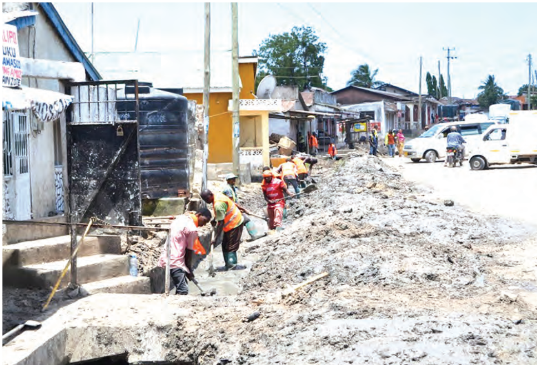
Shughuli za kuchimba mifereji zilipokuwa zikiendelea, Tandale Mtogole, Dar es Salaam.
