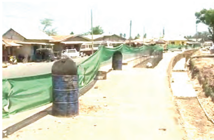
Kazi ya ujenzi wa barabara Sinza - Manzese, Dar es Salaam. Picha zote: MTANDAO.
