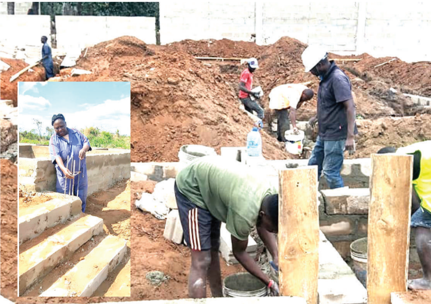
Mwalimu Monica akiwa kazini, wanafunzi wake wakiendelea na ujenzi. PICHA: PILI KIGOME
