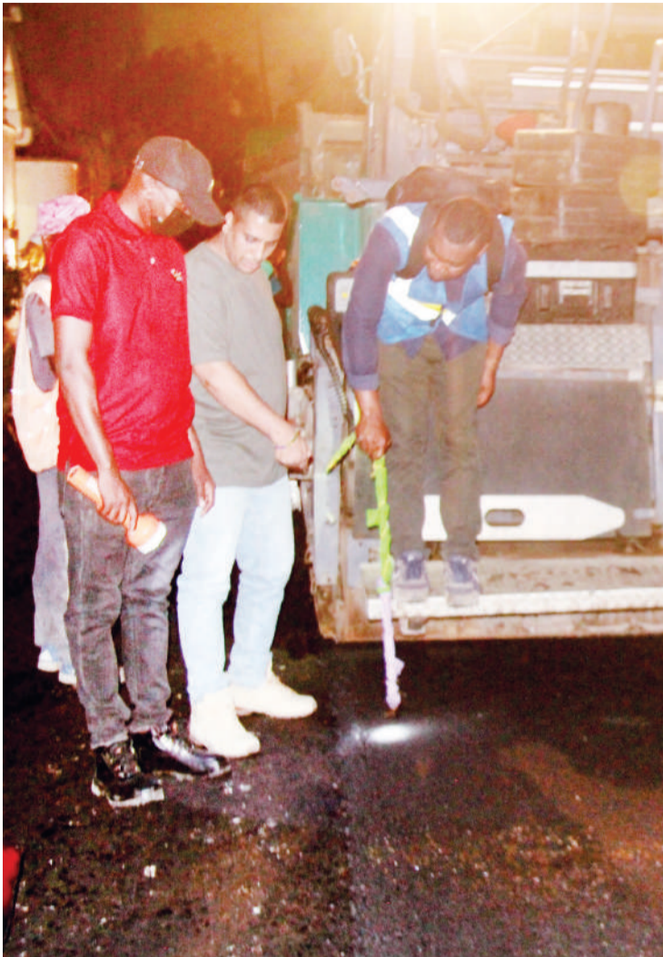
Diwani wa Kata ya Kivukoni Dar es Salaam, Sharik Choughule (wa pili kulia), akiwa na Injiniya wa Wakala wa Barabara za Mijini na Vijijini (TARURA) Wilaya ya Ilala, Regnald Mashamba, wakiangalia uwekaji wa lami kipande cha barabara ya Sea View jijini humo, mwishoni mwa wiki. PICHA: JUMANNE JUMA
