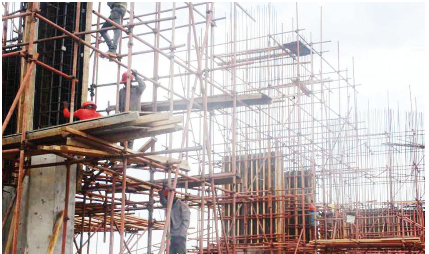
Mafundi wa Kampuni ya ujenzi ya Group Six International, wakiendelea na awamu ya kwanza ya ujenzi wa lango kuu la kuingilia katika mradi wa viwanda vipatavyo 200 wa Sino Tan Kibaha Industrial Park, mkoani Pwani jana. PICHA: MPIGAPICHA WETU
