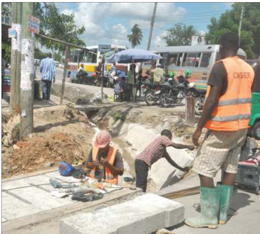
Mafundi wakiendelea na ujenzi wa mifereji ya maji ya mvua katika eneo la Sinza Kijiweni, Manispaa ya Ubungo, jijini Dar es Salaam jana. PICHA: JOHN BADI
