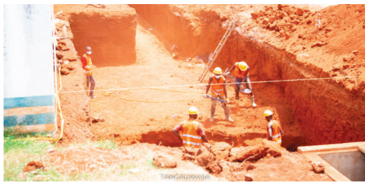
Kazi ya Ujenzi wa Machujio katika Mradi wa Kuboresha Huduma ya Majisafi katika Jiji la Tanga na Muheza Awamu ya Pili.
