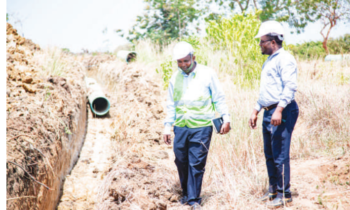
Kazi ya Ulazaji wa bomba kubwa lenye kipenyo cha 600mm na urefu wa Km 12.4 kutoka Mowe hadi Kange katika Mradi wa Kuboresha Huduma ya Majisafi katika Jiji la Tanga na Muheza Awamu ya Pili
