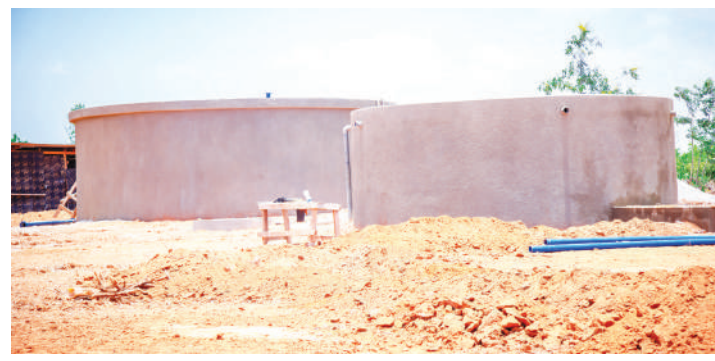
Schemu ya Matenki ya kuhifadhi maji katika Mradi wa ujenzi wa miundombinu ya maji kuboresha upatikanaji wa huduma ya maji maeneo ya mpirani, ndaoya, kibafuta, mleni na chongoleani.
