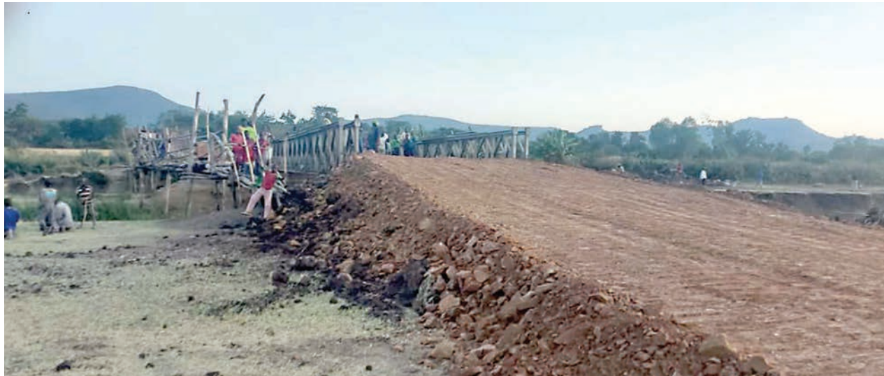
Ujenzi wa daraja jipya la vyuma la Mto Suguti linalounganisha vijiji vya Wanyere na Katarayo, wilayani Musoma, mkoani Mara, ukiwa umekamilika na kufanya wakazi wa maeneo hayo, kuachana na matumizi ya daraja la miti (kushoto), ambalo lilikuwa ni hatari hasa nyakati za mvua. PICHA: MPIGAPICHA WETU
