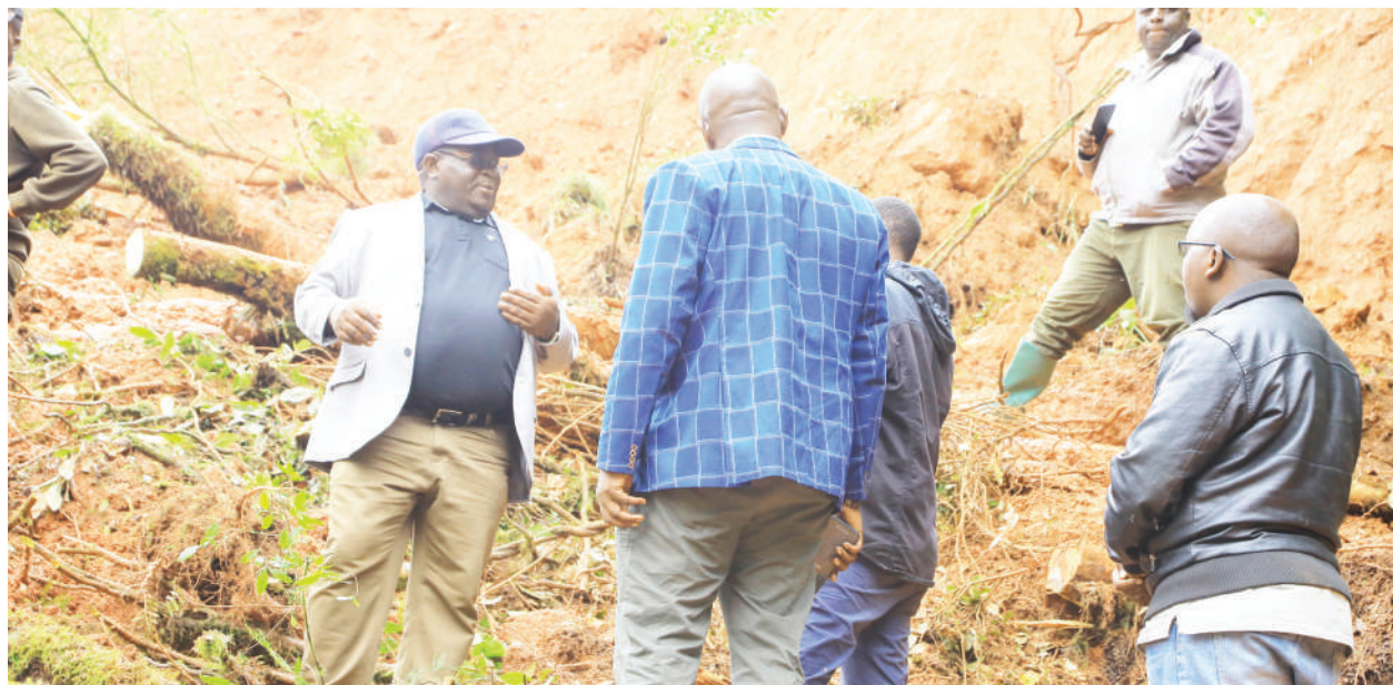
Naibu Waziri wa Ujenzi na Uchukuzi, Mhandisi Godfrey Kasekenya (kushoto) akitoa maelekezo kwa Meneja wa Wakala wa Barabara (Tanroads) mkoa wa Songwe, Mhandisi Suleiman Bishanga, alipotembelea na kukagua barabara inayounganisha kata ya Isongole, Ibungu, Katengele, Lubanda kwenda Keikei, zilizopo wilaya ya Ileje, mkoani humo. PICHA: WIZARA YA UJENZI
