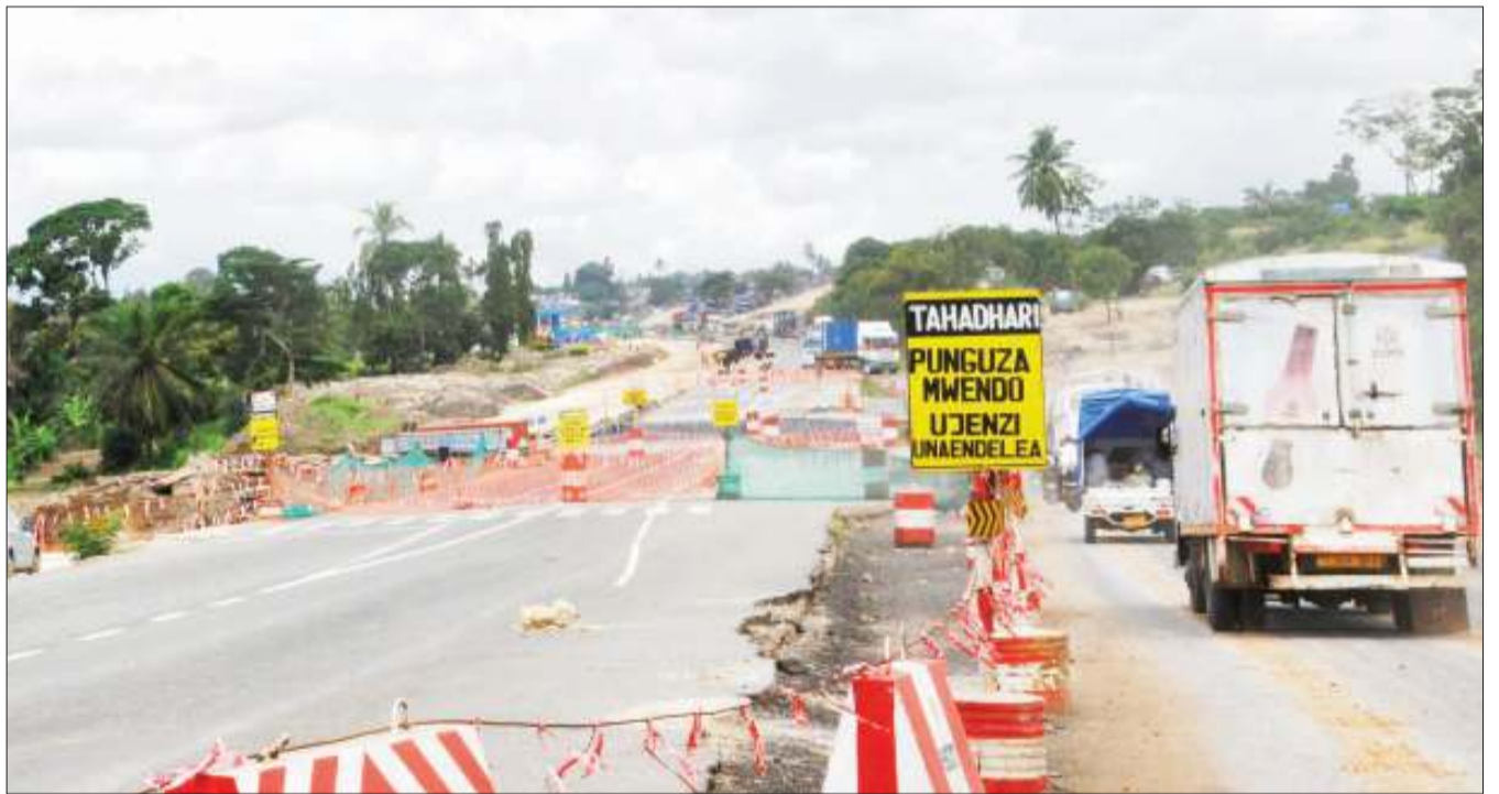
Magari yakipita kwenye njia ya mchepuko upande wa kulia kupisha ujenzi wa daraja kubwa katika eneo la Mbezi Mwisho jijiji Dar es Salaam jana. Hiyo ni awamu ya kwanza ya upanuzi wa Barabara ya Morogoro, itakayojengwa kwa njia sita kuanzia Kimara hadi Kibaha mkoani Pwani yenye urefu wa kilomita 19. PICHA: JOHN BADI
