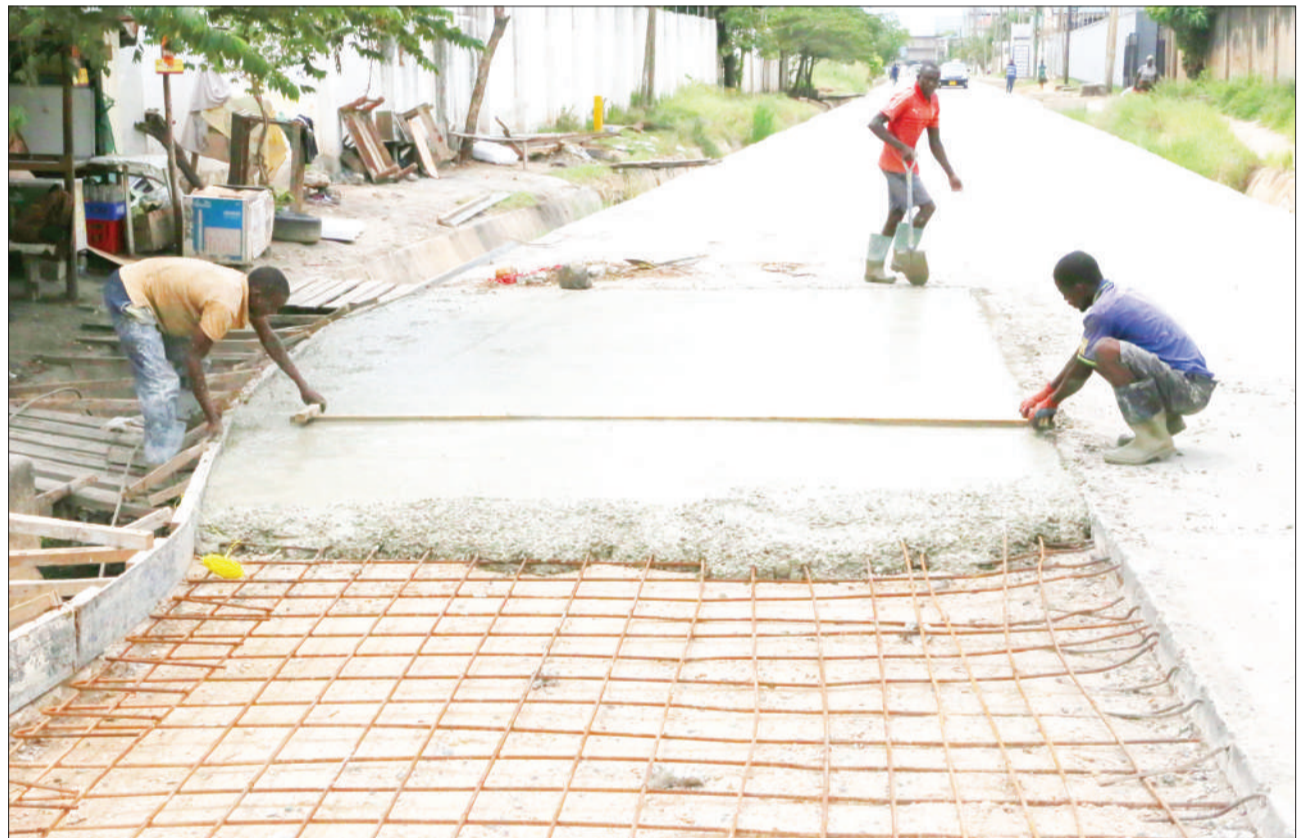
Mafundi wa ujenzi wa barabara wakimalizia kuweka zege kwenye barabara ya mtaa wa Siwa Mikocheni jijini Dar es Sa-laam jana. NA MPIGAPIGA WETU
