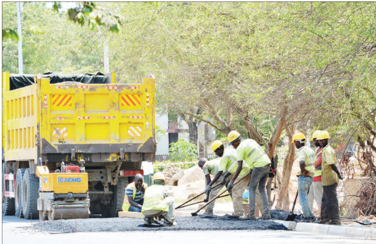
Mafundi wa kampuni ya ujenzi China Railway Seventh Group (CRSG), wakiweka matuta katika eneo la Shule ya Mama Salma Kikwete, eneo la Kijitonyama, jijini Dar es Salaam mwishoni mwa wiki, ili kuyafanya magari yapunguze mwendo.
