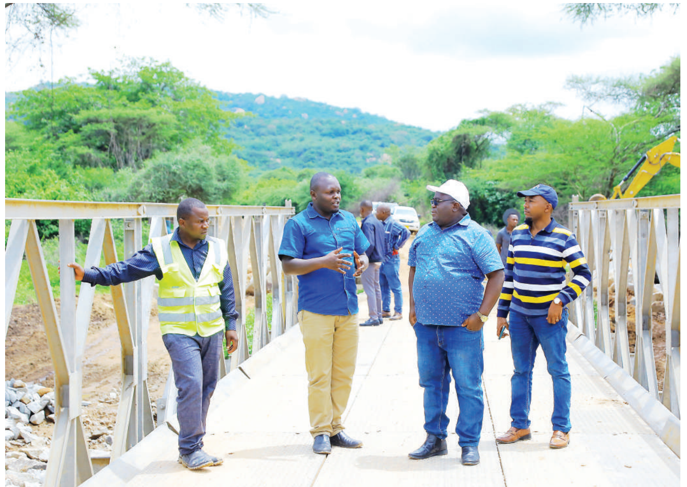
Naibu Waziri wa Ujenzi na Uchukuzi (Sekta ya Ujenzi), Mhandisi Godfrey Kasekenya (wapili kulia), akipata maelezo kutoka kwa Kaimu Meneja wa Wakala wa Barabara (TANROADS), Mkoa wa Dodoma, Mhandisi John Temu, wakati aki-kagua kazi iliyofanywa na wakala huo ya ufungaji wa daraja la chuma katika Mto Bubuku, wilayani Chemba, mkoani Dodoma juzi, baada ya la zamani kukatika na kusimamisha shughuli za usafirishaji katika eneo hilo. PICHA: WUU
