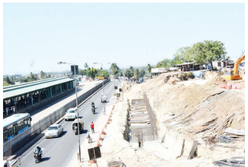
Kazi ya upanuzi wa barabara ya Morogoro kutoka eneo la Kimara Mwisho hadi Ubungu, ikiendelea mkoani Dar as Salaam mwishoni mwa wiki. PICHA: MIRAJI MSALA
