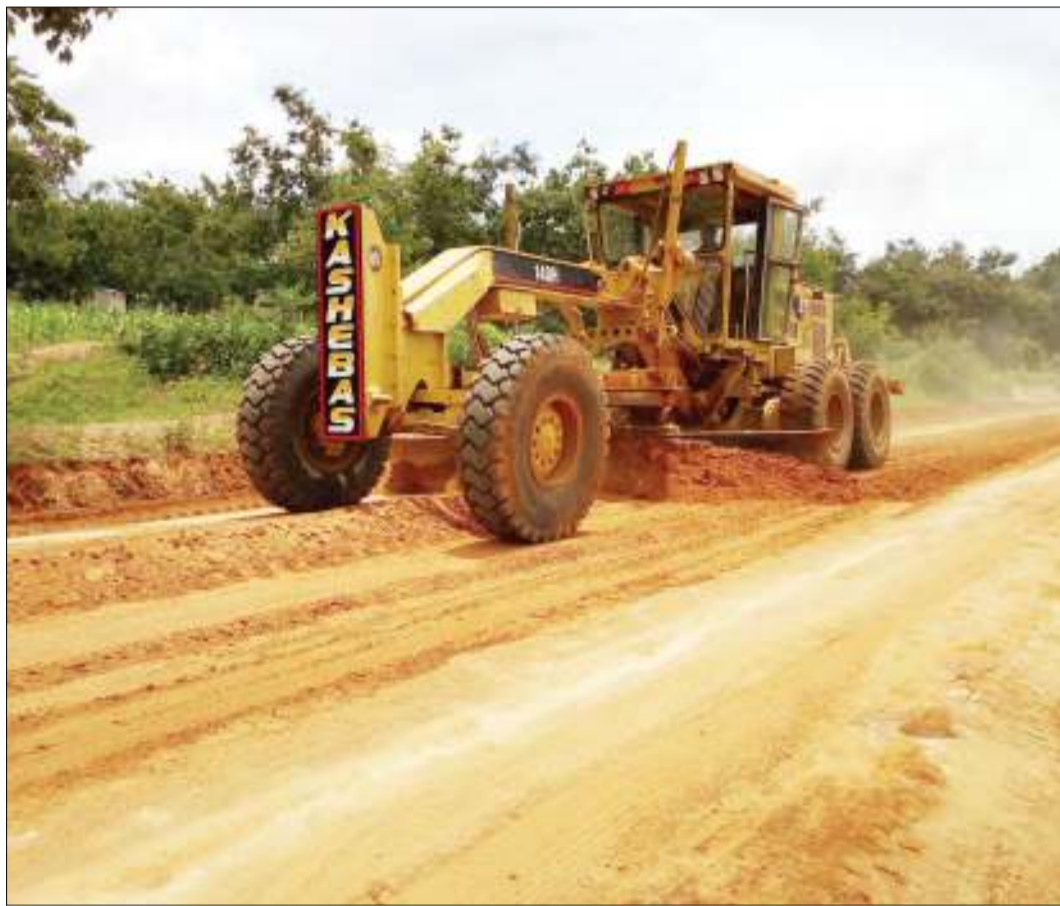
Mkandarasi akitengeneza barabara inayounganisha Halmashauri ya Ushetu na Halmashauri ya Mji wilayani Kahama, mkoani Shinyanga, ikiwamo Wilaya ya Kaliua mkoani Tabora jana. PICHA: SHABAN NJIA
