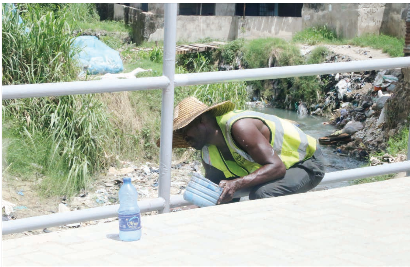
Fundi wa rangi akipaka rangi kwenye nguzo zilizopo katika daraja linalounganisha Mwananyamala kwa Manjunju na Tandale jijini Dar es Salaam jana. PICHA: MPIGAPICHA WETU
