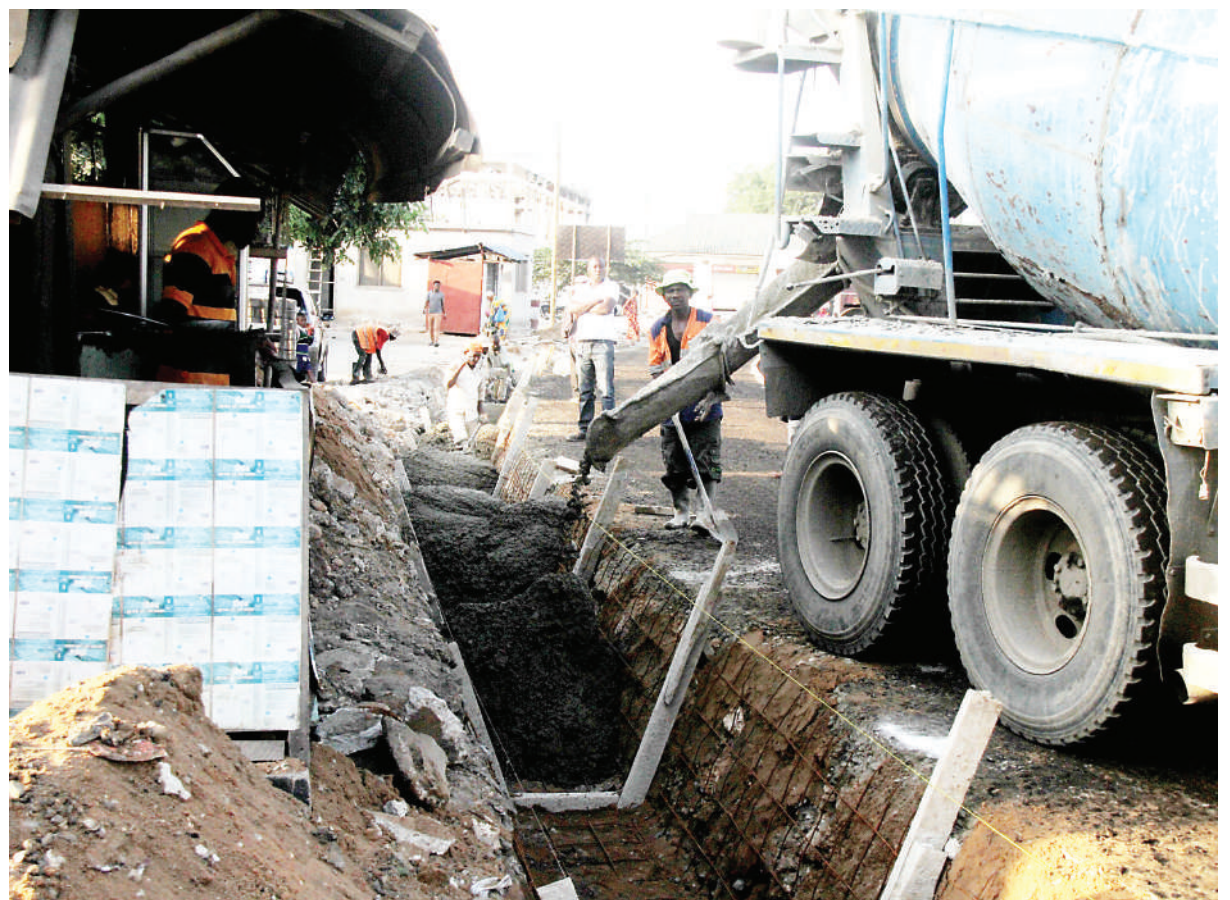
Mafundi wa Kampuni ya Skol, wakiendelea na ujenzi wa mifereji ya maji ya mvua kwenye barabara ya Buza Kanisani, jijini Dar es Salaam mwishoni mwa wiki. PICHA: JUMANNE JUMA
