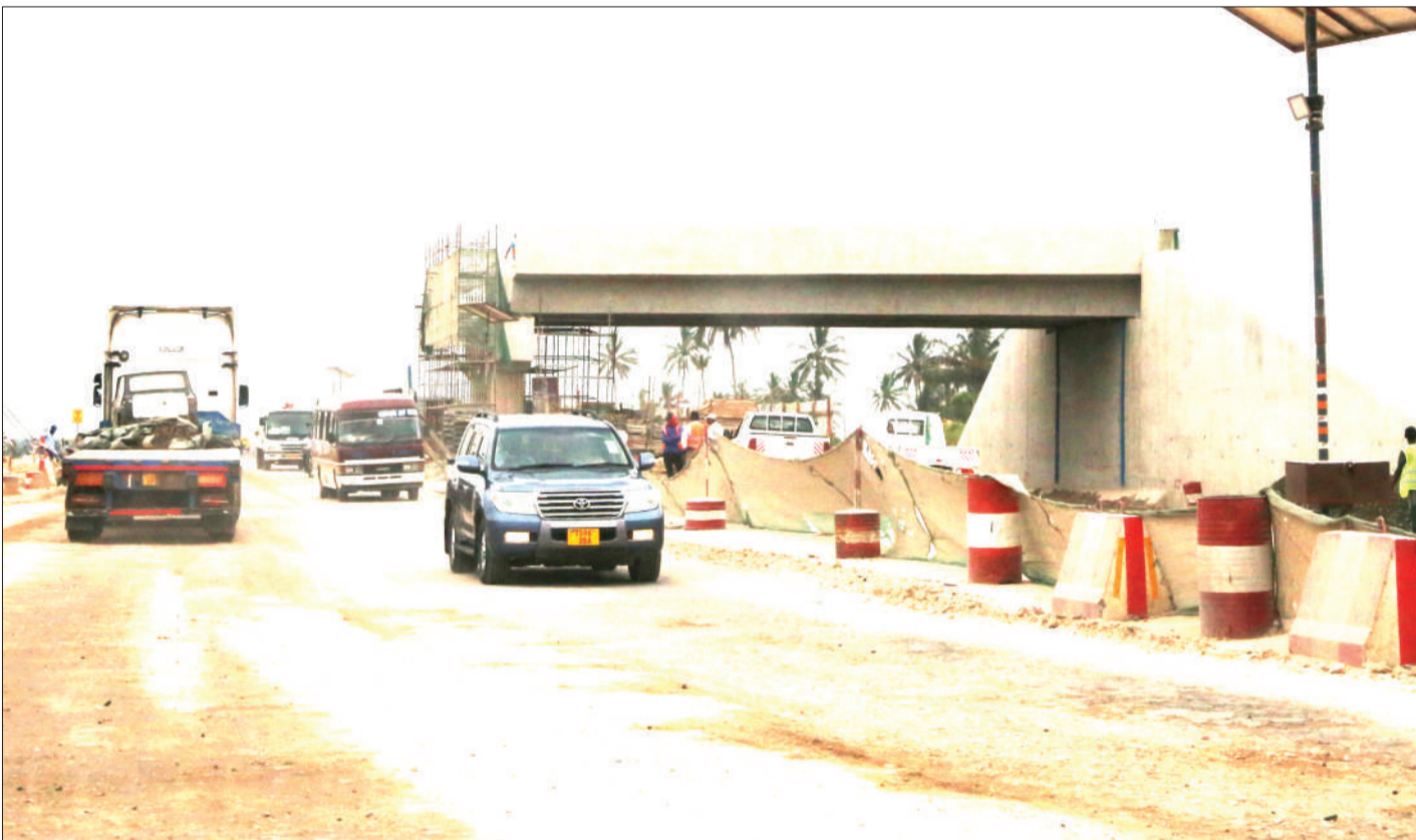
Upanuzi wa barabara ya Morogoro kwa njia sita ukiendelea vizuri, huku kukiwa na mabadiliko kwa baadhi ya maeneo ikiwamo ujenzi wa daraja eneo la Kibamba, wilayani Ubungo, jijini Dar es Salaam jana. Daraja hilo litatumiwa na watembea kwa miguu. PICHA: SELEMANI MPOCHI
