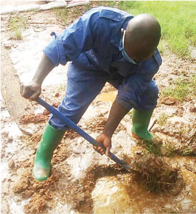
Fundi wa Mamlaka ya Majisafi na Usafi wa Mazingira Dar es Salaam (DAWASA), Bahati Mgaya, akibadilisha bomba eneo la Mlandizi wilayani Kibaha, ili kudhibiti uvujaji uliokutwa eneo hilo. Mamlaka imeendelea kuchukua tahadhali ya kujikinga na corona kwa watumishi wake wanapotekeleza majukumu yao. Picha: MPIGAPICHA WETU
