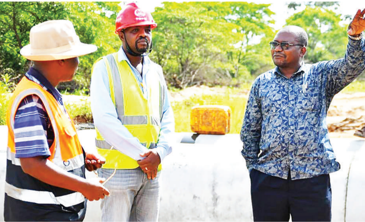
Mbunge wa Kavuu na Naibu Waziri wa Ardhi, Nyumba na Maendeleo ya Makazi, Geophrey Pinda, akisisitiza jambo wakati akikagua maendeleo ya ujenzi wa barabara ya Sitalike- Kibaoni, Mlele mkoani Katavi jana. PICHA: MUNIR SHEMWETA
