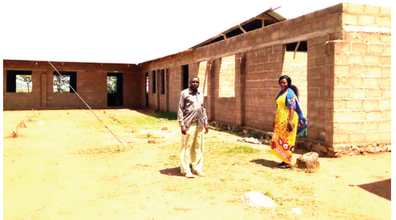
Mtendaji wa Kijiji cha Etaro, Musoma Vijijini, mkoani Mara, Sophia Charles (kulia) na Mwalimu Mkuu wa Shule ya Msingi Etaro, Mangire Mahombwe, wakikagua maendeleo ya ujenzi wa madarasa manne mwishoni mwa wiki. PICHA: MPIGA PICHA WETU
