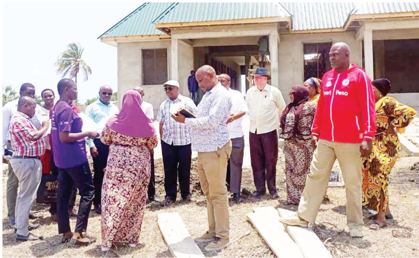
Wajumbe wa Kamati ya Uchumi ya Baraza la Madiwani la Halmashauri ya Jiji la Tanga, wakikagua ujenzi wa jengo la zahanati ya Mtaa wa Kisimatui, Kata ya Pongwe, jijini humo juzi. Kulia ni Diwani wa Kata ya Marungu, Mohammed Mambaa na (mwenye kitabu) ni Ofisa Mawasiliano wa Halmashauri hiyo, Musa Laban. PICHA: BONIFACE GIDEON
