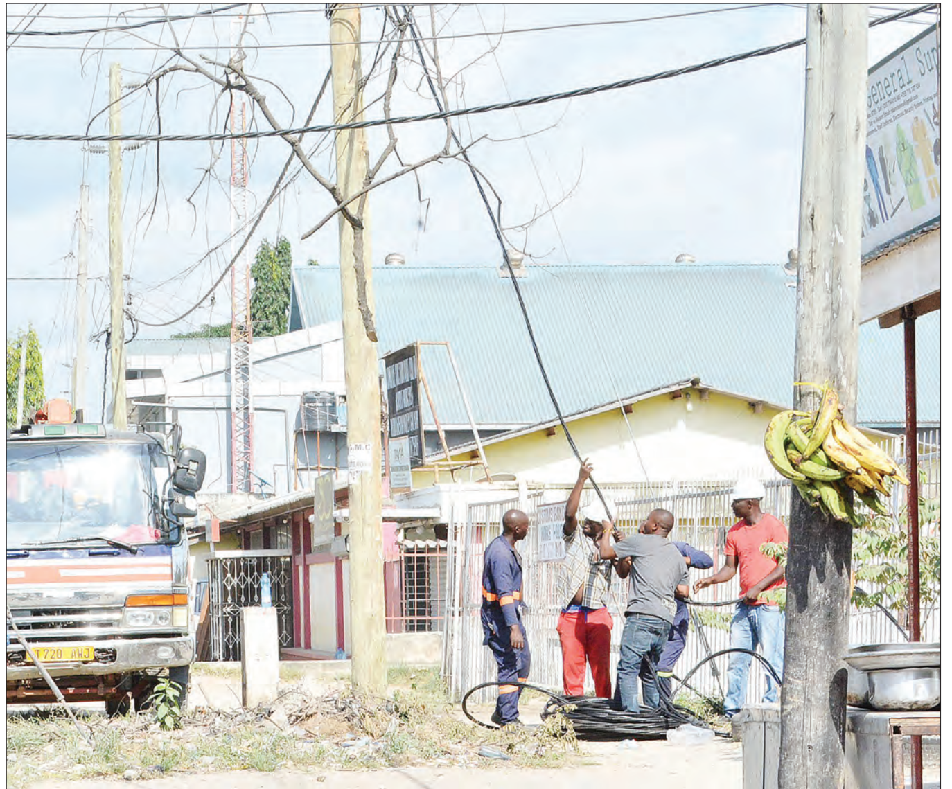
Mafundi wakibadilisha nguzo za umeme ili kupisha ujenzi unaoendelea wa barabara ya Shekilango, katika eneo la Sinza Kijiweni, jijini Dar es Salaam mwishoni mwa wiki. PICHA: MIRAJI MSALA
