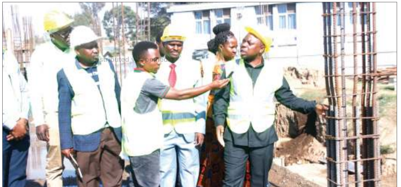
Mkuu wa Mkoa wa Mbeya, Albert Chalamila (kulia), akikagua ubora wa nondo zinazotumika kwenye ujenzi unaoendelea wa jengo la wazazi la Hospitali ya Rufani ya Kanda ya Mbeya, kitengo cha wazazi Meta, mwishoni mwa wiki. PICHA: NEBART MSOKWA
