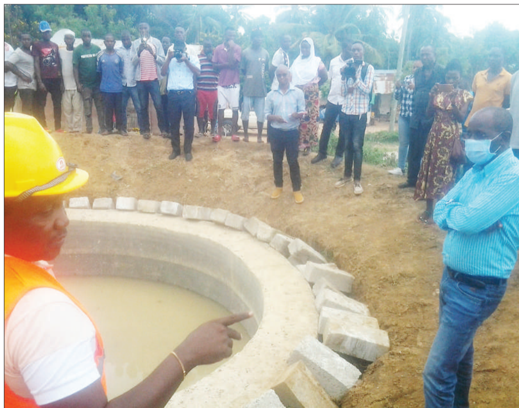
Waziri wa Maji, Prof. Makame Mbarawa (kulia), akisikiliza maelezo kutoka kwa Mkandarasi wa kampuni ya Juin Company Ltd ya jijini Dar es Salaam, Inosent Benard (kushoto), baada ya Waziri huyo kutembelea mradi wa ujenzi wa maji kukagua tenki linalojengwa na mkandarasi huyo katika kijiji cha Umba wilayani Muheza mkoani Tanga. Mradi huo umechelewa kukamilika, hivyo mkandarasi huyo kunusurika kuwekwa mahabusu, na kuagizwa uwe umekamilika kufikia Juni, mwaka huu. Picha: Na STEVEN WILLIAM
