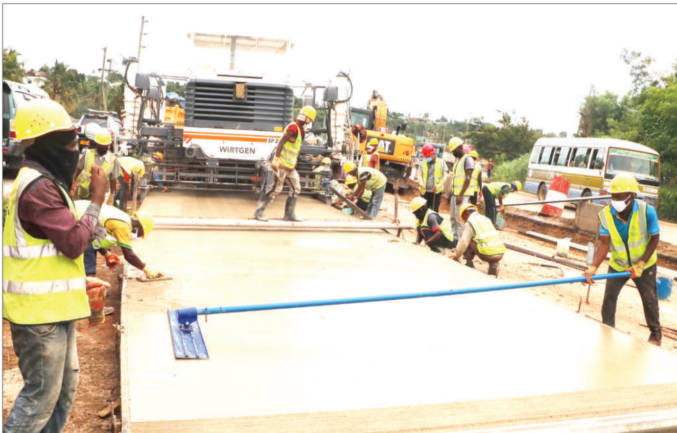
Mafundi wa kampuni ya Hipway Botek, wakiendelea na kazi ya ujenzi wa awamu ya pili ya mradi wa barabara ya mabasi yaendayo haraka kutoka Mbagala hadi Gerezaani, jijini Dar es Salaam jana. PICHA: JUMANNE JUMA
