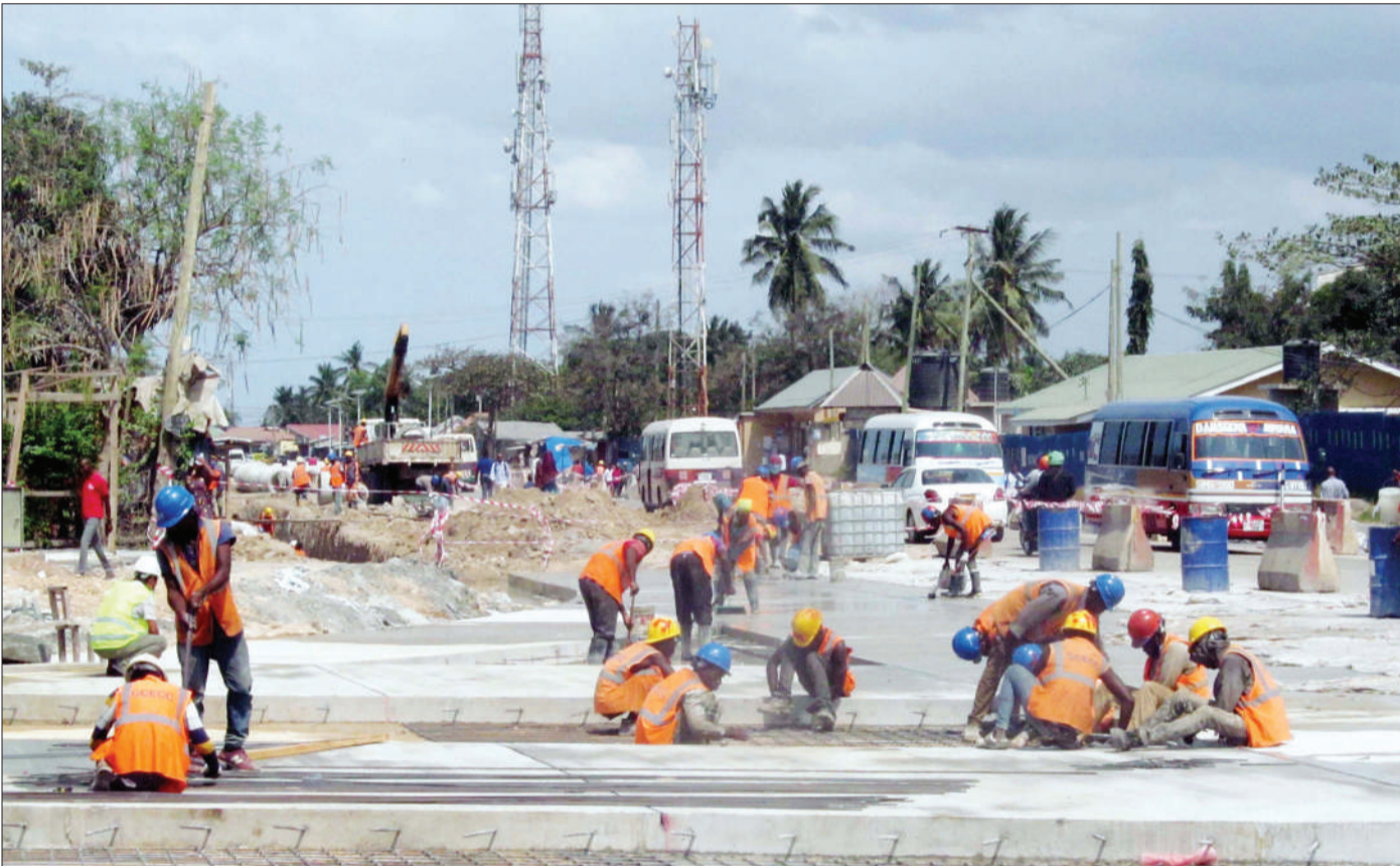
Mafundi wakiendelea na maandalizi ya kujenga makutano ya barabara za Mawasiliano na Sam Nujoma kwa kiwango cha zege, jijini Dar es Salaam jana. PICHA: SABATO KASIKA
