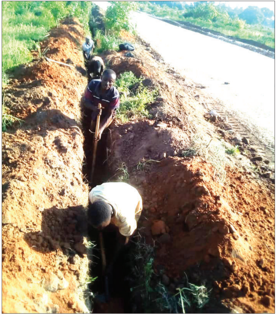
Mafundi wa Mamlaka ya Majisafi na Usafi wa Mazingira Dar es Salaam (DAWASA), wakichimba mtaro kwa ajili ya kulaza bomba la inchi mbili na nne kwa umbali wa kilomita tatu, ili kupeleka huduma ya maji katika nyumba za watumishi wa Halmashauri ya Kigamboni, jijini Dar es Salaam jana. Picha: MPIOGAPICHA WETU
